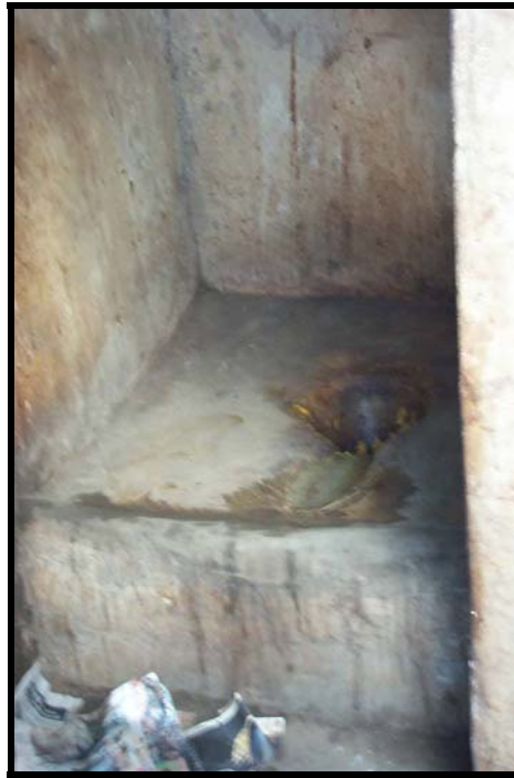
Figure 17: Example of a pour flush latrine
